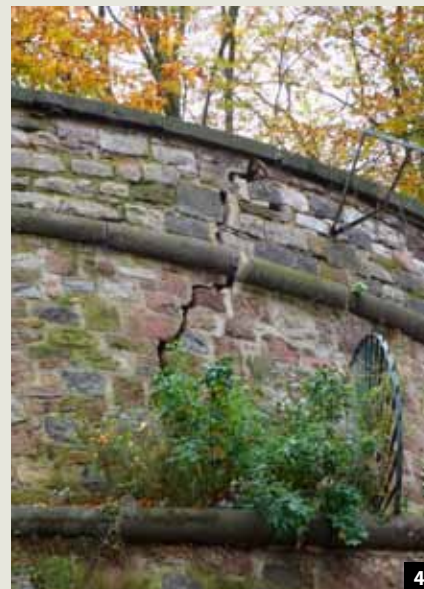
Abb. 4: Die festgestellten breiten Risse machten offensichtlich, dass das Mauerwerk gesichert und statisch ertüchtigt werden musste.
