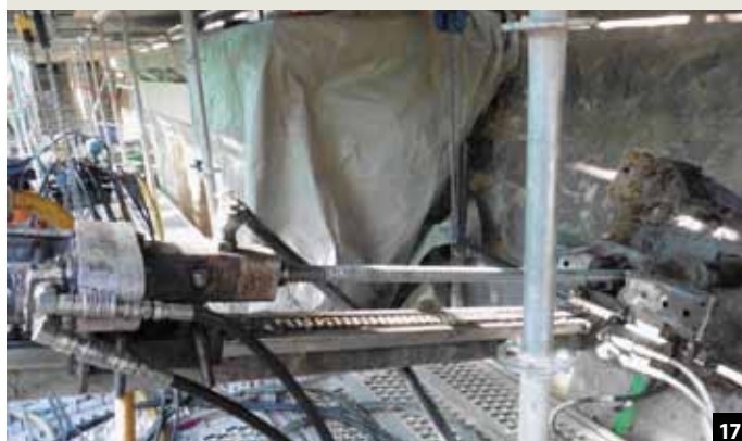
Abb. 17: Die Bohrungen vom Gerüst aus waren wegen des erforderlichen Umsetzens und neu Einrichtens deutlich aufwendiger.
