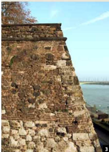
Abb. 3: Die Südostecke drohte aufgrund von Durchwurzlung und ausgewaschenem Fugenmörtel abzugehen. Ein weiterer Grund für die massiven Schäden besteht in den nur notdürftig ausgeführten Reparaturen der Nachkriegszeit.
