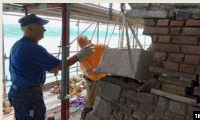
Abb. 18: Dank der Erfahrung der Steinmetze und Maurer konnten auch an komplizierten Stellen wie der Nordost-Ecke die massiven Eckquader ausgebaut und durch neue ersetzt werden.
