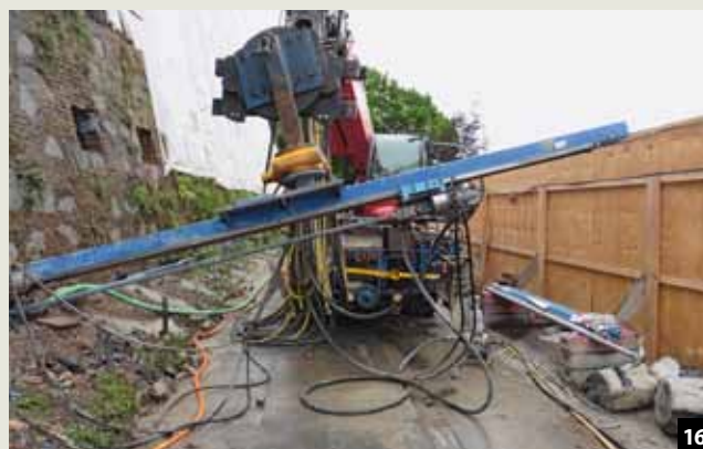
Abb. 16: Das Bohren mit Selbstfahrlafette im Bereich der beiden unteren Lagen ermöglichte eine problemlose Ausführung.
