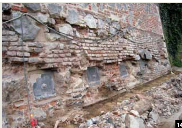
Abb. 14: Ein massiver Einbau von Erdnägeln war besonders am Fuß der über 15 Meter hohen Stützmauer auf der Ostseite notwendig, um einen Grundbruch zu verhindern. Eine zusätzliche Anforderung war, den im Bauwerk von Süd nach Nord laufenden Tunnel bei der Vernagelung zu umgehen.
